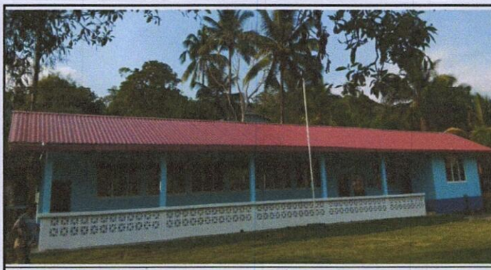
Foto 5: cubierta de lamina
